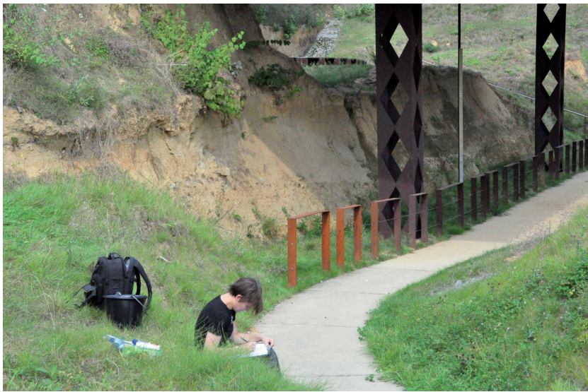
Fig. 2 – Maandelijks inspectie door Monumentenwacht.
