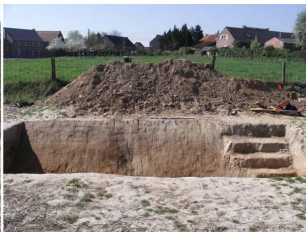
Fig. 17 – Arasement des gradins (a) pour obtenir des parois lisses (b).
