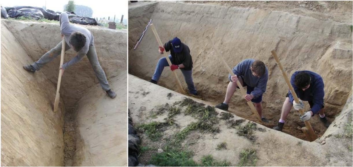
Fig. 19 – Arasement des deux derniers paliers et finition des parois par raclage à la bêche.
