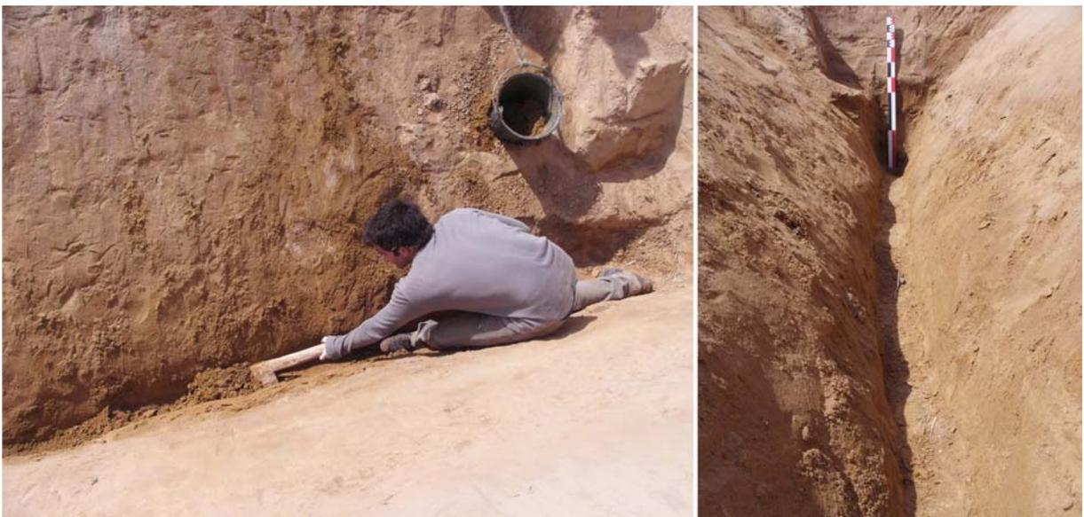
Fig. 20 – Creusement du fond par raclage à la bêche.
