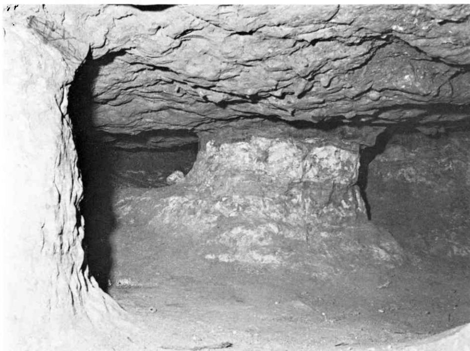
FIG. 8. — Jandrain, un pilier avec un lit de rognons soutient les dalles de silex du toit.
