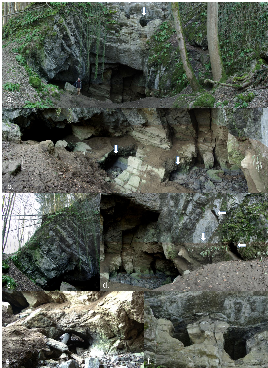
Figures 4 : a. Vue générale de l'entrée du Pré-au-Tonneau. La flèche indique deux passages en « conduite forcée » (voir f) calqués sur les joints de stratification. b. Détail de l'entrée. Les flèches indiquent les restes d'une conduite forcée recoupée et démantelée par l'élargissement de diaclases (fractures verticales sur la photo). c. Détail de la stratification et du découpage par les diaclases. d. Trace de la crue du 7 janvier 2011 (flèche verticale) pendant laquelle le Pré-au-Tonneau a été à saturation, ne permettant plus d'absorption d'eau supplémentaire par le système karstique, et exemple de passages sur diaclase (flèches horizontales). e. Détail de l'ancienne conduite forcée et d'un lit de la Lomme souterraine couvert de cailloux roulés et de blocs effondrés des parois. f. Conduites forcées suspendues (voir a.). – a. General view of the « Pré-au-Tonneau » entrance. The arrow indicates two passages with « pressure pipe » section (see f). b. Entrance detail. The arrows point to the remains of an « pressure pipe » recut and dismantled by pressure release (decompaction) of joints (vertical fractures on the picture). c. Detail of stratification and jointing. d. Trace of the flooding (vertical arrow) on 7th of January 2011 during which Pré-au-Tonneau reached the saturation level. At this moment, no further absorption of surface water by the karstic system was possible, and example of passages on joints (horizontal arrows). e. Detail of the former « pressure pipe » and the bed of subterranean Lomme covered with rolled pebbles and with blocks collapsed from the walls. f. Suspended pressure pipes (see a.)
