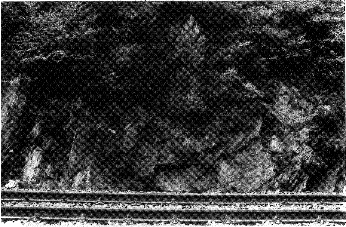
Photo. 5c - Vue de la paroi de tranchée représentée par la figure 13 ci-dessus.
