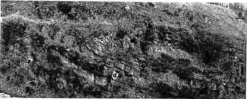
PLANCHE I. — Tranchée de chemin de fer à 2,5 km au Nord de la gare de Dolhain; paroi sud.
