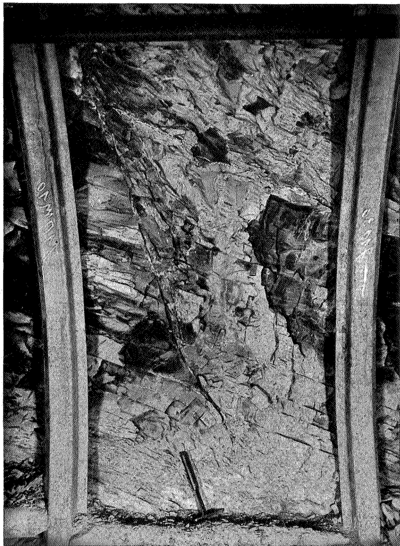
FIG. 2. — Mouvement de rotation entre des fissures à fort pendage; une seule visible sur la photo.
