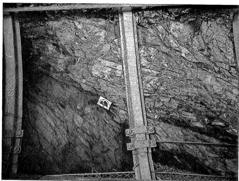
FIG. 5. — Passage de la faille « Bertiaux » à 639,50 m. (Le clinomètre a 0,09 m x 0,14 m et indique 18°.)
