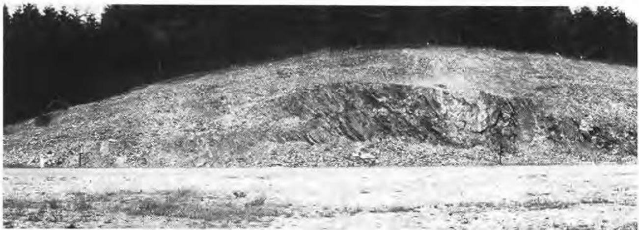
Fig. 5. — Talus oriental de la route de Ligneuville à Kaiserbaracke et St-Vith, le long du ruisseau de Rôba. (La balise routière blanche, à l'extrémité gauche de la photographie, est située au km 6,670 de la route).
