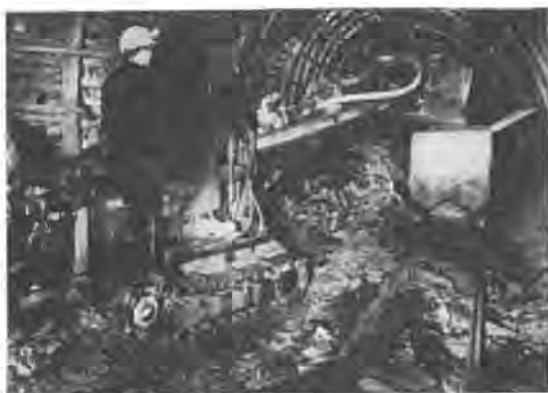
Fig. 3. Chargeuse spéciale Hausherr pour les travaux de rabassenage.
