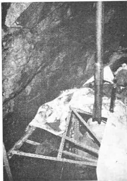
Fig. 18. — Vue du refuge vers le nord (avec soutènement provisoire).
