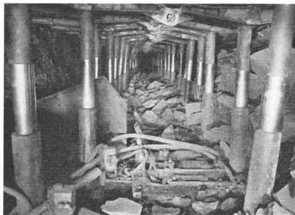
Fig. 10. — 34e/20. Pompe en taille, protection enlevée.
