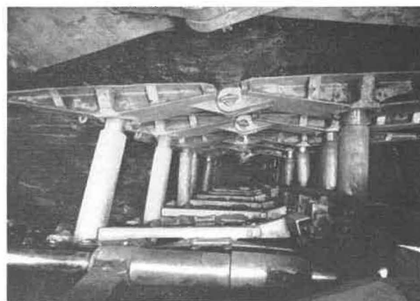
Fig. 2. — Soutènement marchant Westfalia en service dans une taille de la S.A. des Charbonnages du Borinage (extraite de l'article de MM. VANDEVELDE et BOLLE, A.M.B., janvier 1962).
