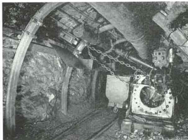
Fig. 3. — Le crochet de fixation de la chaîne au train de bacs est fixé au f'asque de la caisse entre les deux lames de couteau (installation de scraper-robot à chaîne en service au siège n° 10 du Gouffre).
