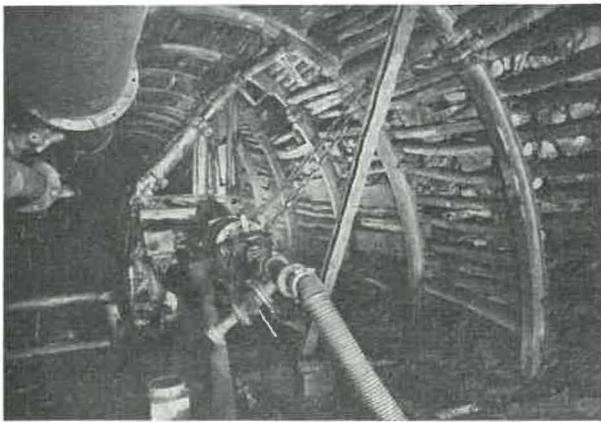
Fig. 18. — Vue de la voie de base avec tête motrice, dispositif et rail de calage, sortie des chaînes, sortie de charbon, cloisonnement de protection et panzer de chargement.
