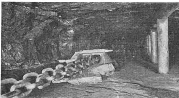
Fig. 17. — Vue du bélier avec les chaînes. On remarque les lumières évidées, le couteau-haveur coudé, la semelle et les masses soudées.
