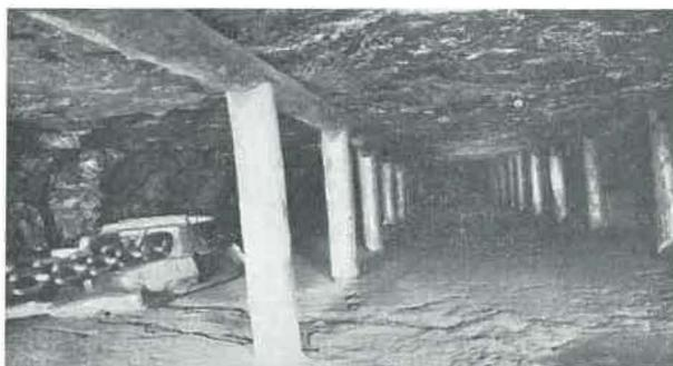
Fig. 21. — Vue plongeante dans la taille avec bélier, soutènements par plats et par points et cloisonnement pour les remblais.
