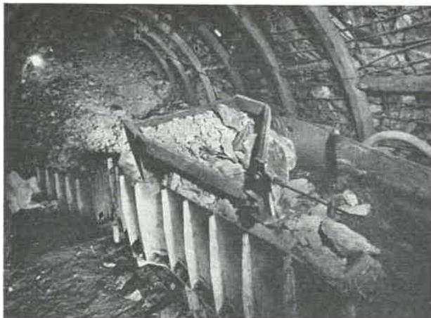
Fig. 31. — Chargement sur transporteur à courroie par scraper-houe et estacade, dans un bouveau plantant à 14°, en creusement. Le scraper-houe achemine sa charge de terres sur l'estacade vers la trémie de chargement sur le transporteur à courroie.
