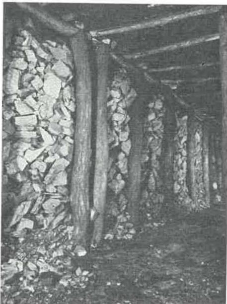
Fig. 17. — Remblayage en taille par scraper dans une taille de grande ouverture (2,20 m) avec une pente de 15° à 20°. Vue prise de la havée des fronts.
