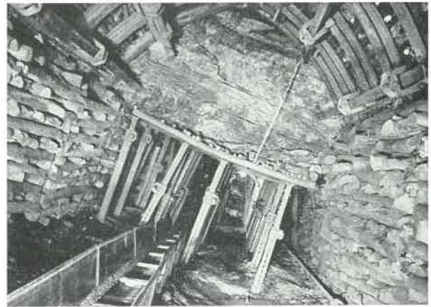
Fig. 37. — Le front de bossement de la voie de base, 5 m derrière la taille.
