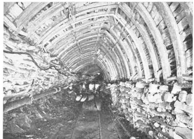
Fig. 45. — Passage du tronçon C (88 cadres lourds) au tronçon D (cadres légers). La photo est prise quatre mois après la pose du premier cadre léger. La voie reste belle derrière la taille.
