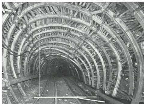
Fig. 22. — Vue du tronçon A, 10 mois après son recarrage. La section est réduite de moitié. Les mouvements continuent.
