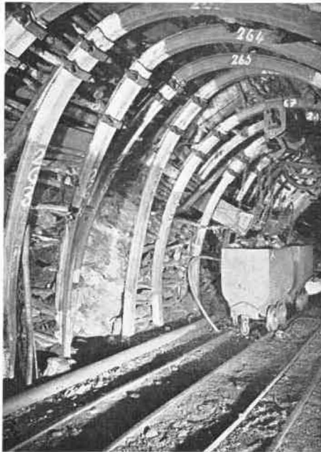
Fig. 18. — Déformation des cadres au passage de la taille, à 10 m du front de la voie (cfr. fig. 8 qui représente le front de la voie le même jour). On entaille le mur pour replacer les montants enlevés au pied de taille (cadre n° 265 par exemple).
