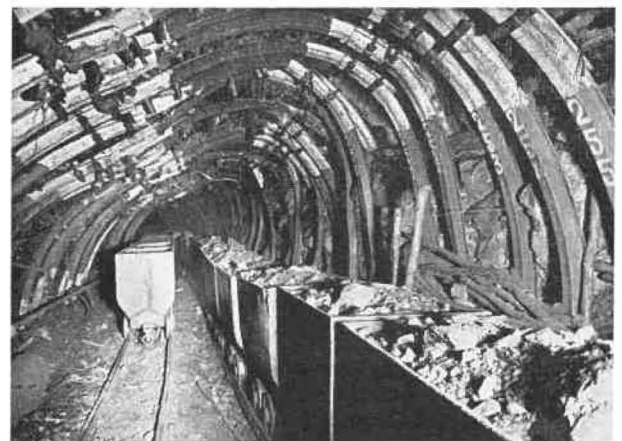
Fig. 17. — Vue du pied de taille vers les puits. Le cadre 251 est à 20 m du front de la voie.
