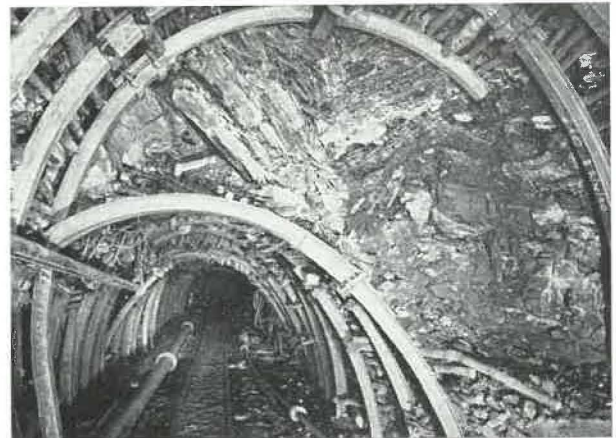
Fig. 7. — En mars 1960, à 270 m du front de taille, on recarre pour la 3 me fois la voie à l'endroit où la photographie de la fig. 2 avait été prise 10 mois plus tôt.
