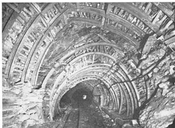
Fig. 34. — Photographie des 10 cadres coulissants le 29 août, soit 6 1/2 mois après le creusement, à 120 m de la taille. Les pieds de cadres pénètrent dans la roche. Les pièces de cadres se déforment.
