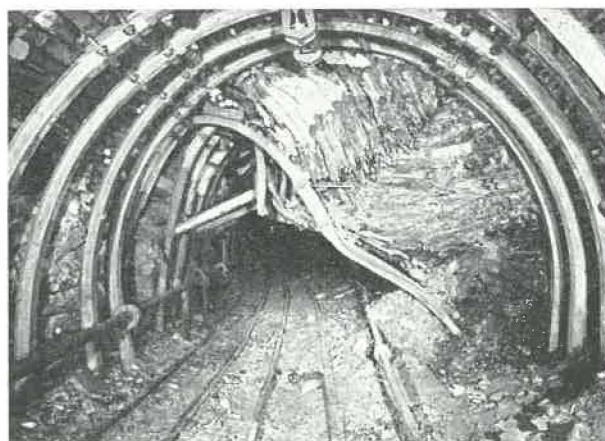
Fig. 28. — Brèche de recarrage dans le tronçon B à 53 m du front de la voie. Le claveau de béton empêche la pénétration du montant dans la sole. Le montant plie. La cassure des bancs de toit prend la direction de fuite du soutènement.
