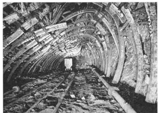
Fig. 20. — Déformations des cadres coulisants sur claveaux de béton dans le tronçon A des mesures à 50 m du front de la voie.
