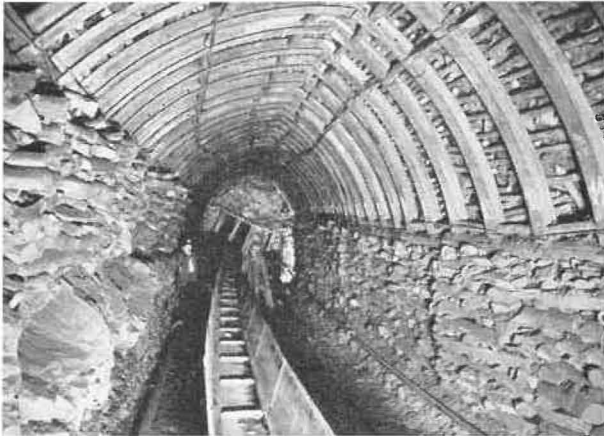
Fig. 38. — Le tronçon C en cadres articulés sur piles de bois photographié le 19 mars 1960. Vue montrant qu'il est facile de circuler de chaque côté du convoyeur.
