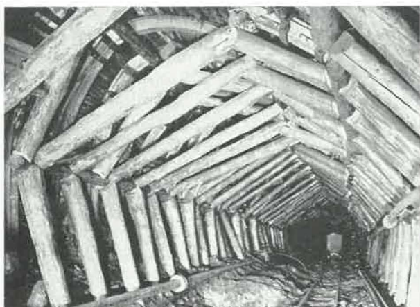
Fig. 27. — Boisage anglé en renforcement des cadres coulisants T.H.W. — Vue du front de la voie et du pied de taille. Les cadres se déforment. Les bancs de mur se soulèvent. La photographie est prise peu avant l'achèvement de la remise à niveau de la voie des pleines (rabasnage).
