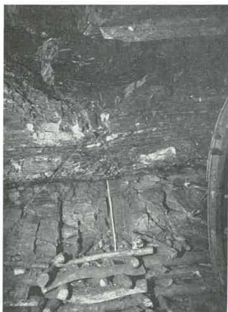
Fig. 32. — Cassure en coin dans la paroi amont de la fausse-voie.
