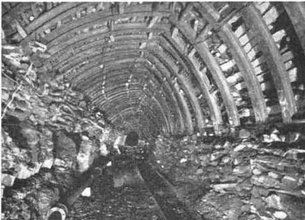
Fig. 39. — Le même tronçon C en cadres articulés sur piles de bois photographié le 11 septembre 1960, soit 6 mois plus tard. Les piles sont fort écrasées. La voie reste belle sans entretien.
