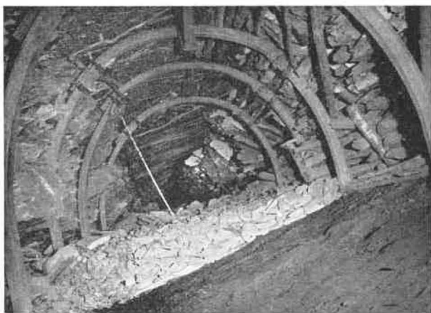
Fig. 31. — Vue de la fausse-voie vers l'arrière. La dalle de toit tient sans autre soutènement qu'un épi de remblai de part et d'autre, celui d'amont étant soutenu par une pile de bois.
