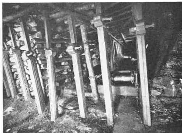
Fig. 25. — Vue du pied de taille avec pile d'amont.
