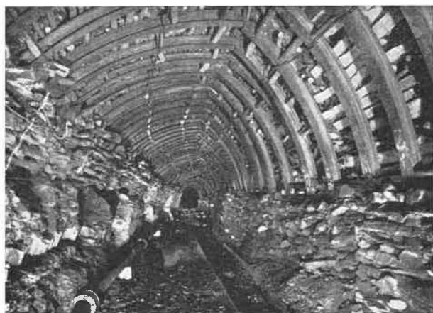
Fig. 30. — Photo de la galerie en cadres articulés.
