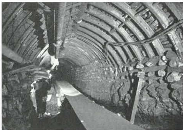
Fig. 2. — Voie de pied d'une taille dans une couche de 1,60 m d'ouverture remblayée pneumatiquement, à 250 m du front de taille (6 mois d'existence).
