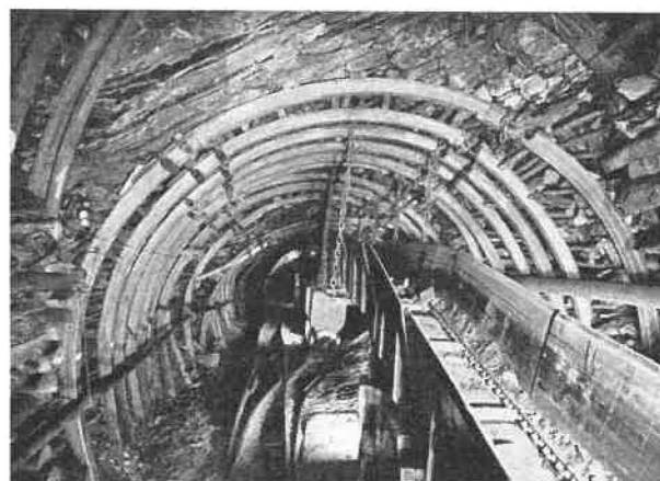
Fig. 31. — Cadres 563 à 572 placés après passage de la taille et épaulés par une pile de bois de chaque côté. Photographie du 10 mai, soit 3 mois après la pose.
