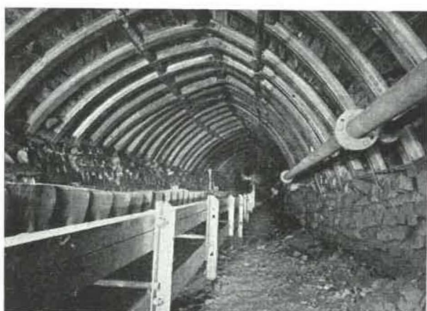
Fig. 9. — Vue d'un tronçon de galerie.
