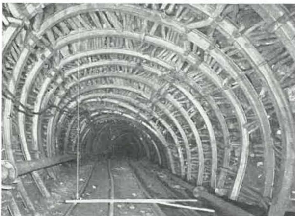
Fig. 16. — Voie en cours de déformation après un premier recarrage.
