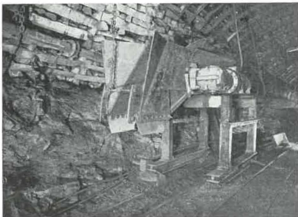
Fig. 21. — Photo du point de chargement.
