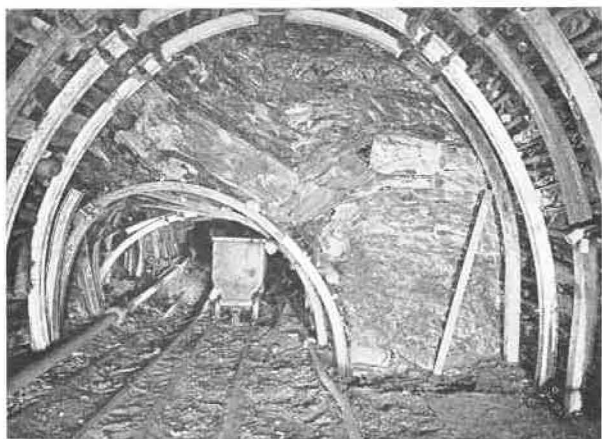
Fig. 13. — Vue du recarrage dans la voie revêtue de cadres Toussaint-Heintzmann placés sans semelle sur la roche.
