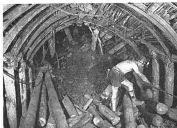
Fig. 15. — En enlevant le fer n° 1, le fer n° 3 est également tombé; ils ont été tous deux retirés vers l'arrière. On enlève le pilot se trouvant sous le fer n° 2 (solution la plus facile).
