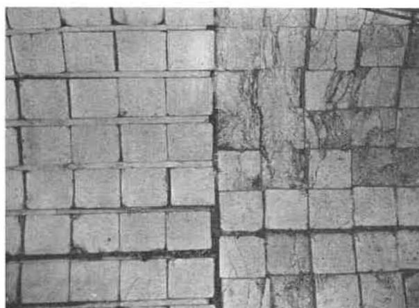
Fig. 7. — Photographie de la paroi d'un bouveau revêtu de claveaux de béton dans le bassin de Campine (charbonnage de Beeringen). A gauche, début de la section avec planchettes intercalaires et à droite, sans planchettes.
