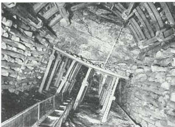
Fig. 28. — Photo du creusement de la voie. Soutènement provisoire et soutènement définitif.
