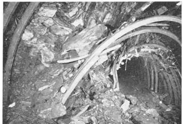
Fig. 8. — Siège n° 10 — Vue d'une brèche de recarrage dans la voie de Grosse Fosse couchant au niveau de 730 m, 2 ans après l'arrêt du chantier. La vue est prise vers les fronts à 187 m du front de taille, soit à 273 m de l'entrée de la voie. On remarque très bien la cassure en V caractéristique qui s'est dessinée à la paroi de la galerie (à gauche sur la photo).
