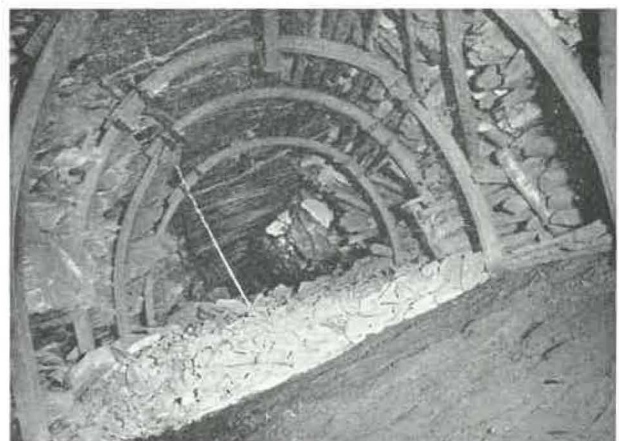
Fig. 18. — Fausse-voie cadrée. Vue vers l'arrière montrant la dalle de toit.
