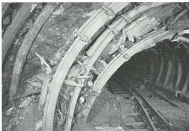
Fig. 10. — Siège n° 10 — Aspect de la voie de Grosse Fosse couchant au niveau de 730 m, à hauteur d'une brèche de recarrage située à 57 m du front de taille, soit à 403 m de l'entrée de la voie. La vue est prise vers les fronts, 2 ans après l'arrêt du chantier, dans un tronçon qui avait été, à l'origine, revêtu de cadres Toussaint à 29 kg/m.
