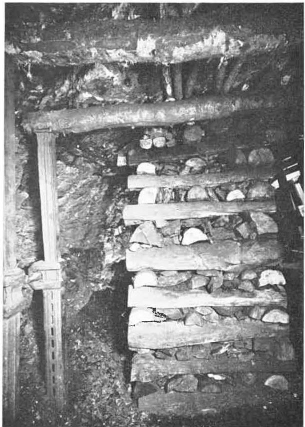
Fig. 26. — Vue arrière de la niche avec pile d'aval.
