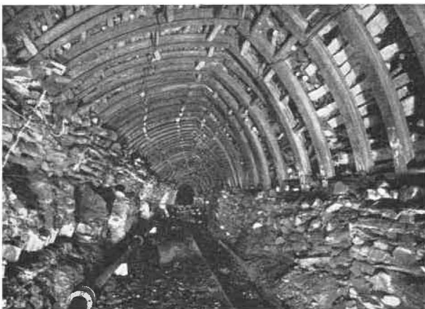
Fig. 30. — Photo de la galerie en cadres articulés.
