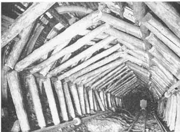
Fig. 14. — Photo de la galerie renforcée par boisage anglé avec brèche de rabasnage en cours.
