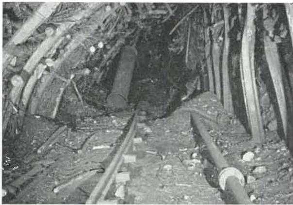
Fig. 9. — Siège n° 10 — Aspect de la voie de Grosse Fosse à 8 m du pied de taille. On remarque que les cintres Toussaint à 21 kg/m fortement rapprochés — intercadre 0,50 m — fluent nettement vers la taille, côté paroi nord (à droite sur la photo), tandis qu'une cassure s'amorcera à paroi sud et déterminera une forte poussée des terrains.
