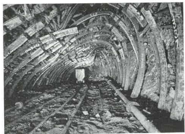
Fig. 12. — Vue de la galerie 50 m en arrière des fronts. Voie déformée avant recarrage.
