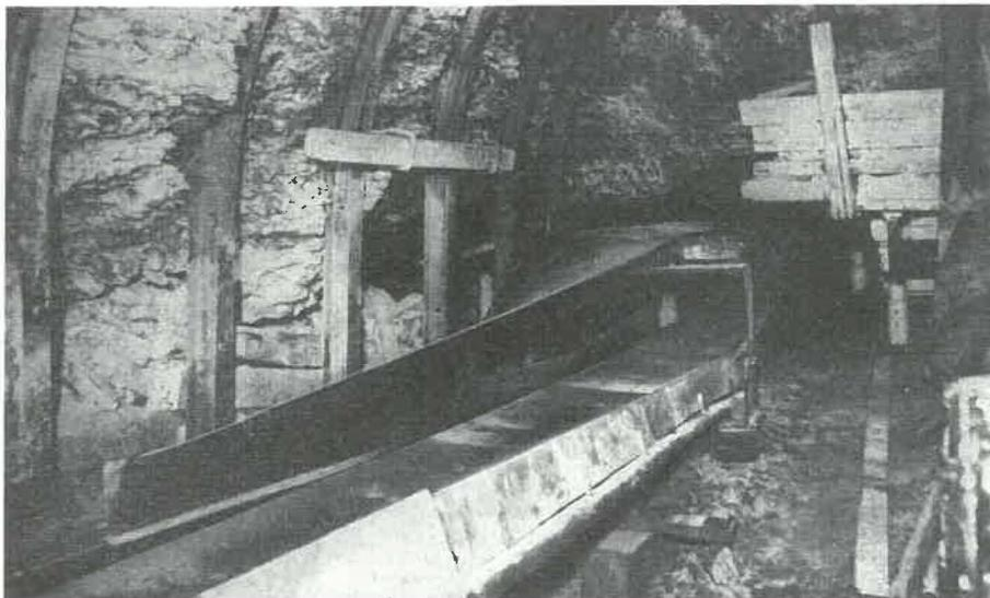
Fig. 9. — Conveyeur à brin inférieur porteur avec déversement supérieur et retournement de 180° du brin de retour par passage latéral.
