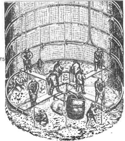
Fig. 24. — Vue de plancher de forage utilisé pour l'amorçage des trous de mine.
