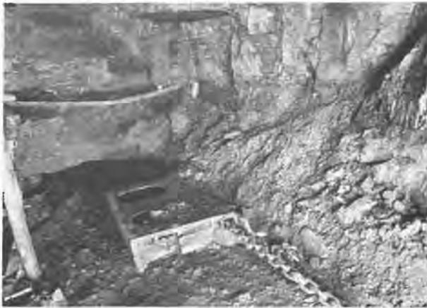
Fig. 18. — Vue du dérangement, la présence d'eau en grande quantité dans le toit a provoqué la chute de celui-ci. Le scraper entamait le mur, 1 mètre en dessous de la veine.
