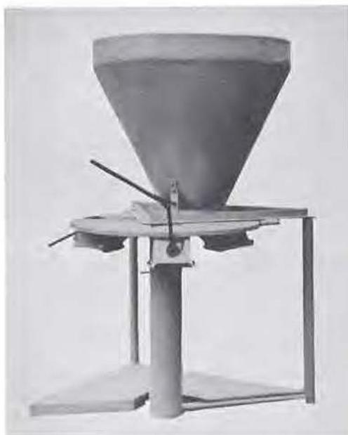
Fig. 40. — Machine de la firme Theuke utilisée pour le remplissage des sacs de sable.
