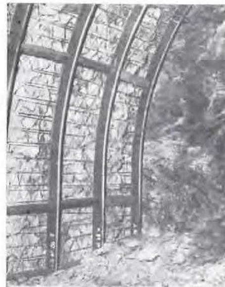
Fig. 8. — Galerie équipée d'un garnissage métallique Löbbert.
