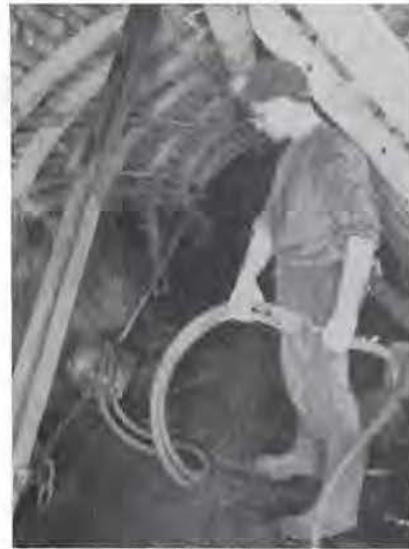
Fig. 38. — Palan à air comprimé Hadel utilisé au désassemblage d'une voie.
