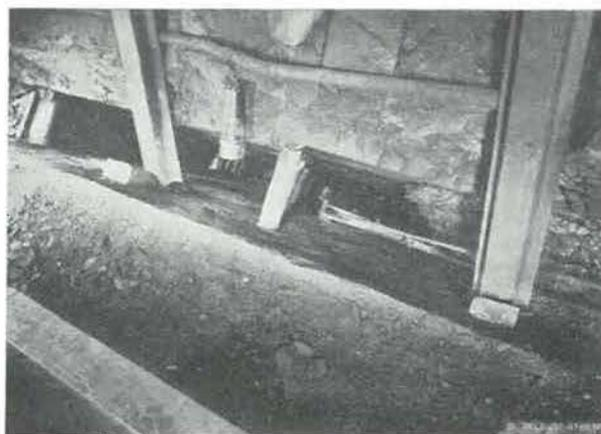
Fig. 13. — Abattage par scie Neuenburg. Vue plongeante montrant la scie en tête de taille.
