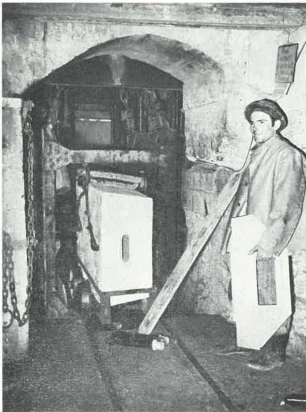
Fig. 10. — Chargement du truck dans la cagette. On remarque : à droite, le plat vertical qui sera glissé dans la cheminée centrale; au centre, les 2 broches  $t_1$  et  $t_2$  pour suspendre le claveau au plat central; dans la main de l'homme, la planchette qui s'intercale dans les points horizontaux des claveaux.
