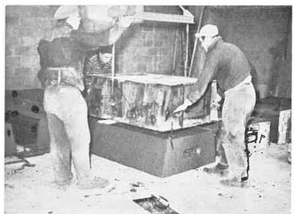
Fig. 28. — Démoulage d'un clavier.
