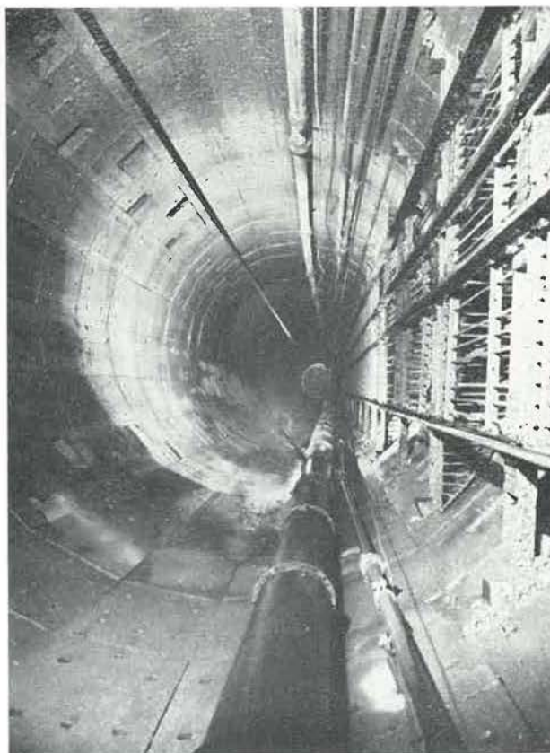
Fig. 21. — Vue générale du revêtement du puits (on remarque à droite les guidages en rails pour les cagelettes).
