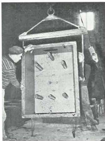
Fig. 23. — Moule M pour la fabrication des claveaux.
