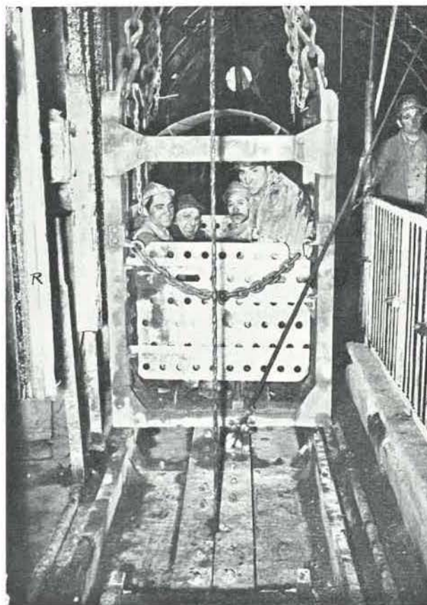
Fig. 1. — Cagette pour tous les transports dans l'avaleresse en creusement, y compris celui des déblais.
