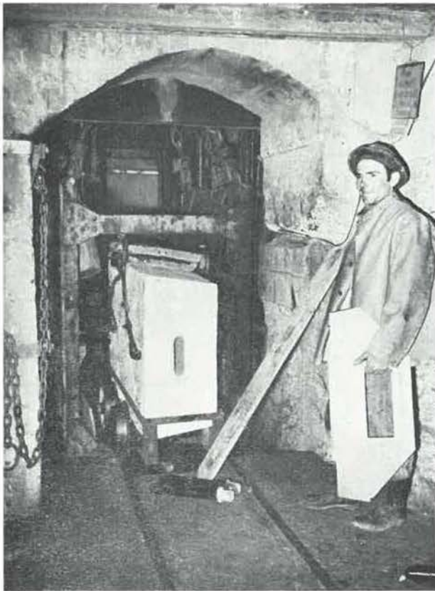
Fig. 10. — Chargement du truck dans la cage. On remarque : à droite, le plat vertical qui sera glissé dans la cheminée centrale; au centre, les 2 broches t_1 et t_2 pour suspendre le claveau au plat central; dans la main de l'homme, la planchette qui s'intercale dans les points horizontaux des claveaux.
