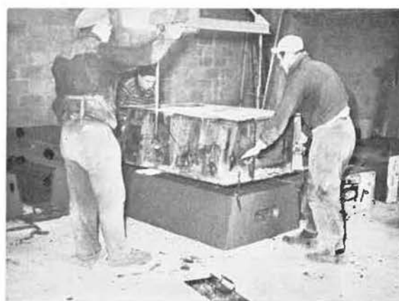
Fig. 28. — Démoulage d'un claveau.
