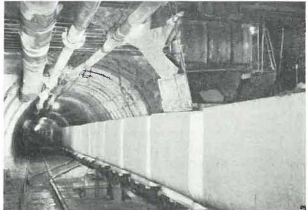
Fig. 16. — Point de chargement central et berlines de 3.500 litres.
