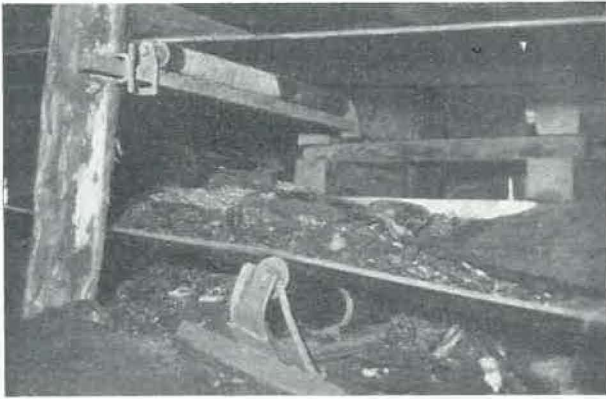
Fig. 5. — Couiroie à brin inférieur porteur supportée de distance en distance par de petites batteries de rouleaux en augets.
