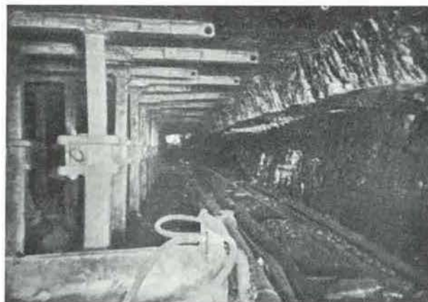
Fig. 6. — Ripage du convoyeur après passage de la havéuse dans les deux sens (après les phases d'abatage et de nettoyage).
