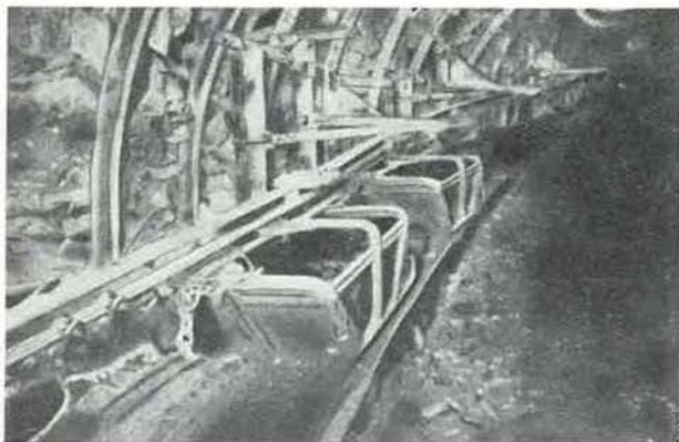
Fig. 3. — Installation de raclage en courbe. Une main courante est fixée au câble tracteur tous les 3 m et glisse le long d'un rail qui épouse la forme de la courbe. Les racloirs sont suspendus au câble tracteur.
