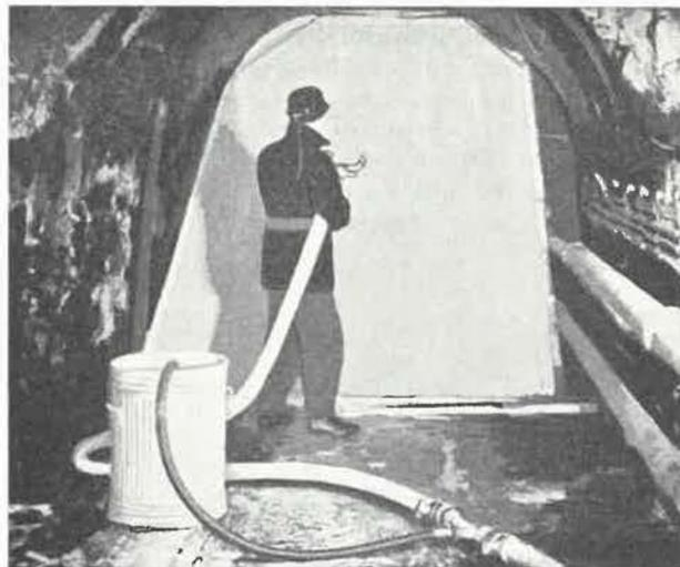
Fig. 75. — Arrosage du filet tendu au travers de la galerie.
