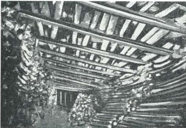
Fig. 6. — Fers U posés sur piles de bois; la roche est renforcée par des boulons qui traversent les fers U.
