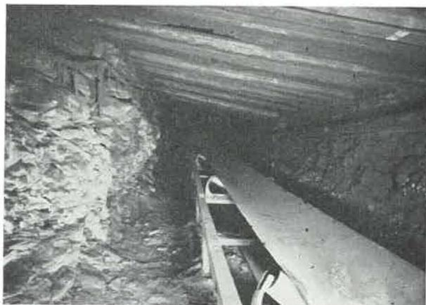
Fig. 4. — Rails posés sur piles de bois placées dans l'ouverture de la couche. Le toit est resté intact et le bosseyement a été pris entièrement dans le mur.
