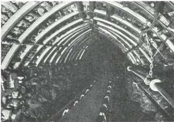
Fig. 11. — Cadres articulés posés sur piles de bois compressibles édifiées dans toute l'ouverture de la couche.
