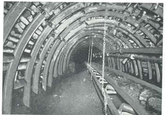
Fig. 9. — Cadres Toussaint-Heintzmann en 5 éléments; Vue prise après le passage de l'exploitation des 2 côtés de la voie, profil de 29 kg/m.
