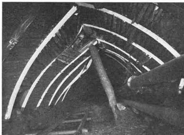
Fig. 30. — Voie de tête. Déformation de la branche aval du cadre sous l'effet d'un affaissement dissymétrique aux cadres 46 et suivants.
