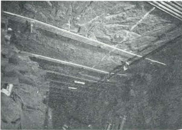
Fig. 5. — Bèles Ougrée posées sur piles de bois édifées dans l'ouverture de la couche. Pour renforcer la roche, on a boulonné le toit.
