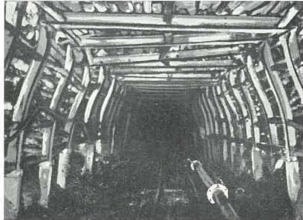
Fig. 3. — Exemple de cadre trapézoïdal avec caissons coulissants (caisson Cerlach).
