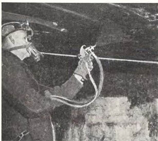
Fig. 2. — Application du filu. L'opérateur projette la couche de fond après le peignage. On remarque que le peignage a été étendu à 20 cm sous le toit.
