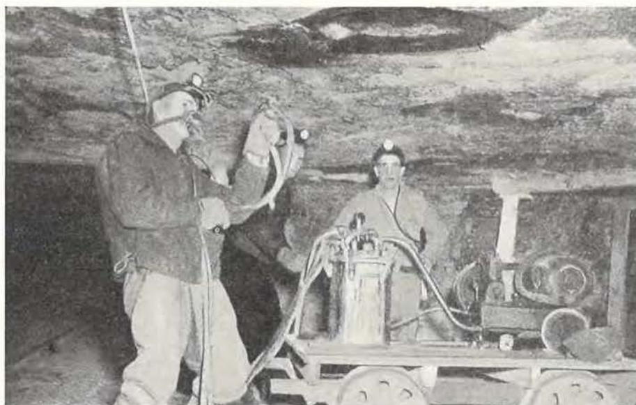
Fig. 1. — Le matériel est monté sur un wagonnet léger pour faciliter les déplacements. Il est garé dans une galerie transversale pour permettre l'application de l'enduit dans la galerie de roulage principale pendant les postes de travail.
