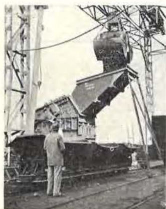
Alimentation d'un broyeur à chocs « HAZEMAG » avec blocs de minerais de Type AP 5 (débit 200-250 T./h.) 1-1,5 m 3 de grandeur.
