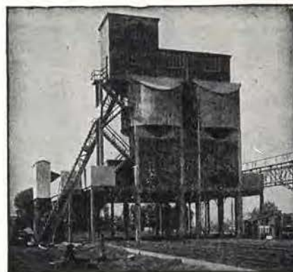
Installations de manutention et distribution de charbon.
