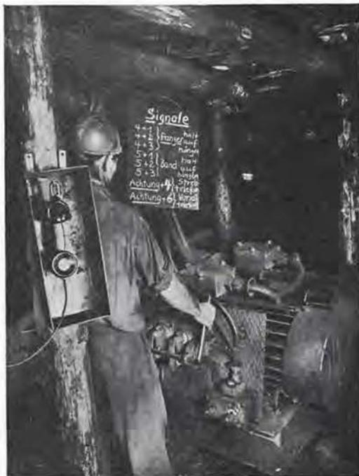
Fig. 8. — Commande principale du convoyeur blindé avec appareil double.
