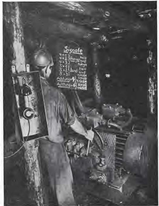
Fig. 8. — Commande principale du convoyeur blindé avec appareil double.
