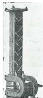
b Fût supérieur de l'étauçon garni de cordons de soudure en métal dur.
