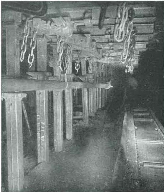
Fig. 24. — Taille équipée de bèles Scheer-Dragon, en acier. Les bèles sont maintenues en porte-à-faux par des sabots de rallonge.
