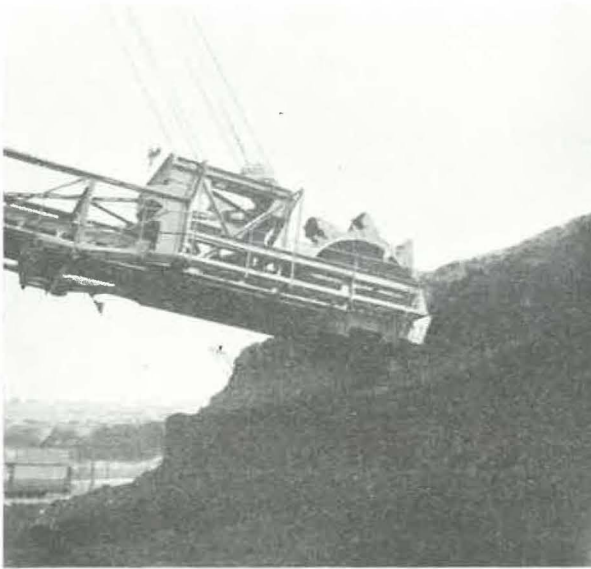
Photo II. — Mine de Zukunft, à Weisweiler. Excavateur à roues à aubes.
