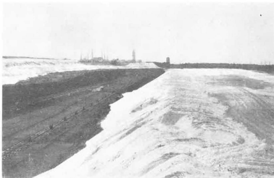
Photo VI. — Mine de Hürtherberg. Vue générale. — A droite, déblai en place.
