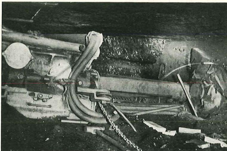
Fig. 7. — Machine du type surbaissée dans une taille de 1,05 m d'ouverture avec mur soufflant.
