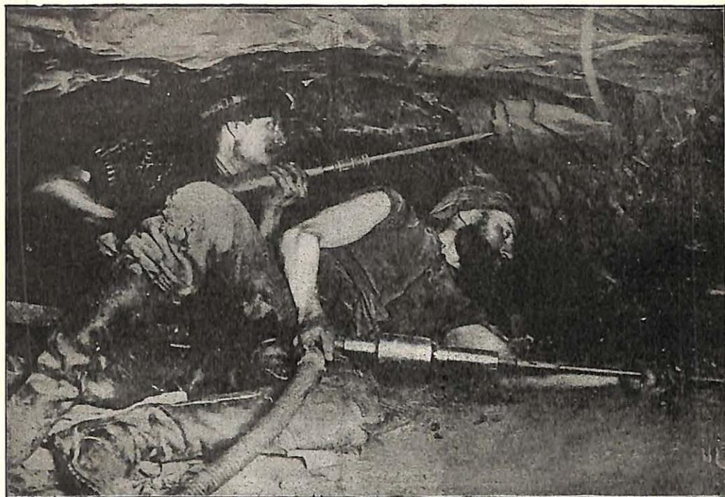
FIG. 9. — Creusement des trous de mine.
