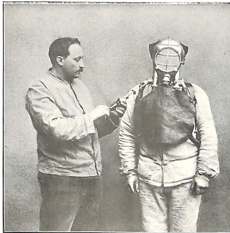
Fig. 73. — *Prise d'essai d'oxygène régénéré.*
