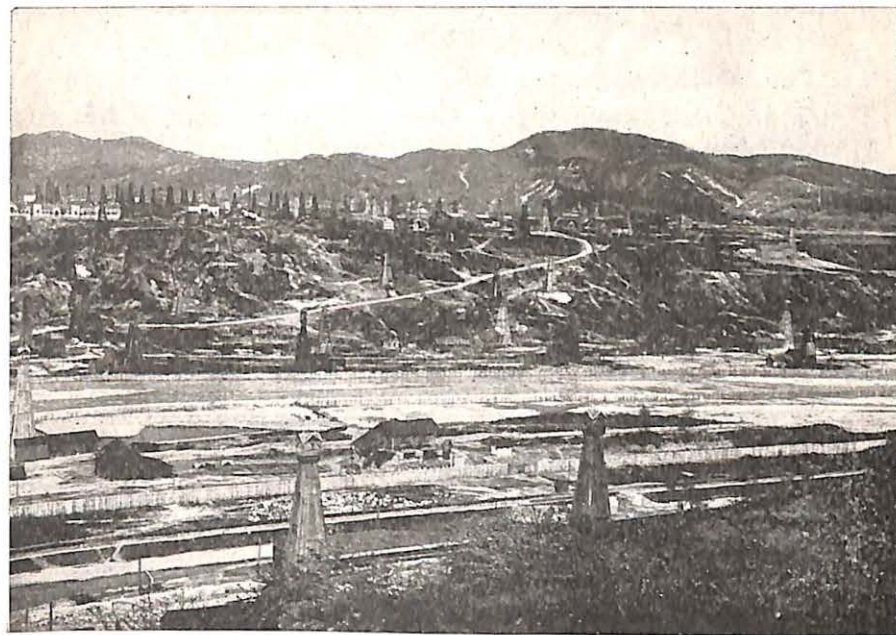
FIG. 7 — Campina. — Chantiers de Grafita et de Vrajitoarea. Vallée de la Prahova.
