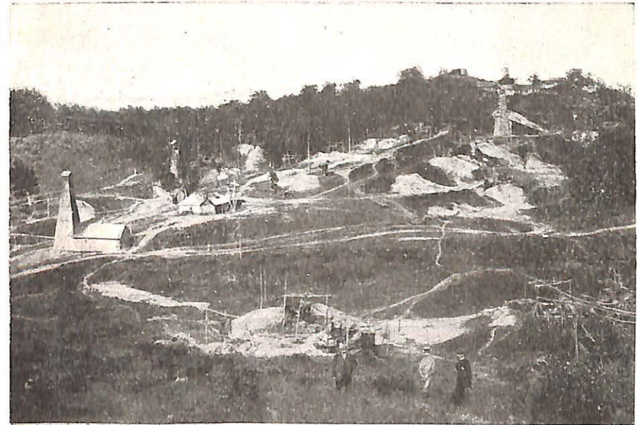
FIG. 8. — Chantier de Colibasi.
