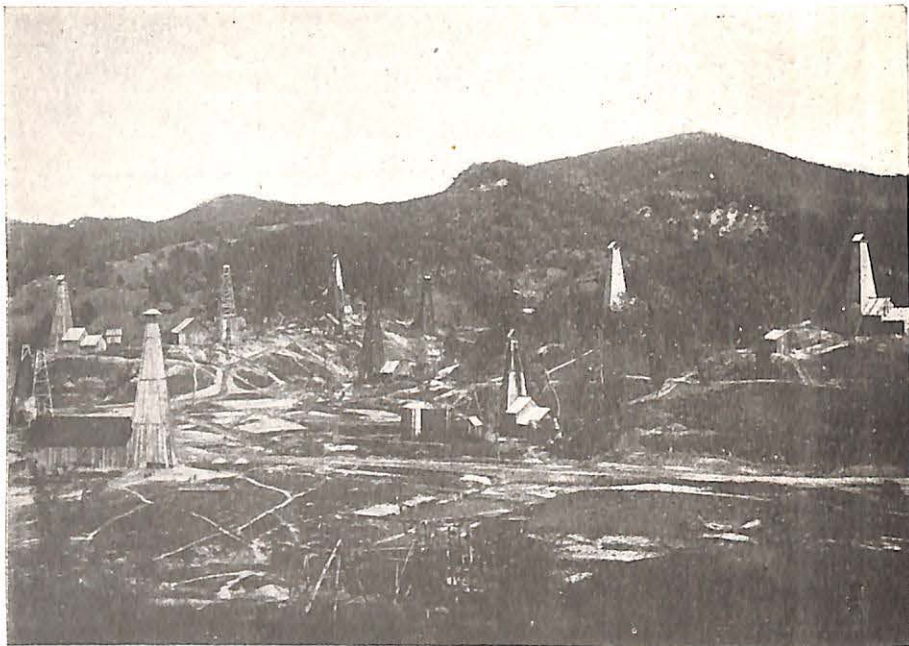
FIG. 2. — Recea. — La vallée du Doftanet et le chantier.
