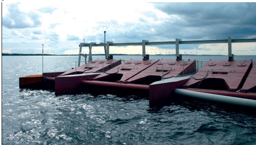
Figuur 1.18. Testfase van de Poseidon (bron: www.floatingpowerplant.com )
