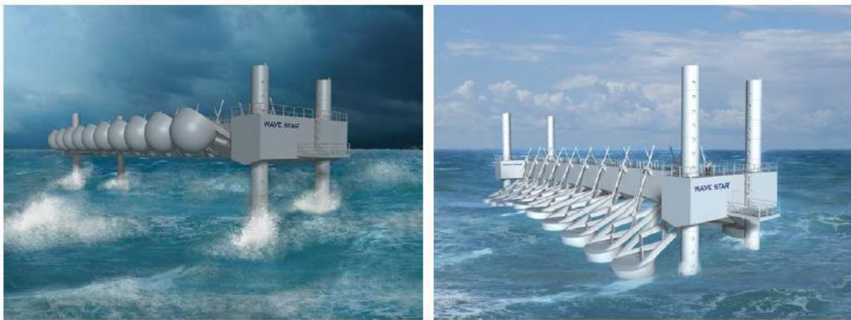
Figuur 1.16. Een ontwerp van de Wavestar. Links in stormcondities met de vlotters opgetrokken als beveiliging, rechts onder normale omstandigheden (bron:wavestarenergy.com)
