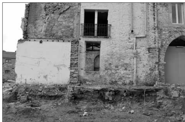
Mur-pignon fermant la nef côté est et montrant en haut le vestige d'une arête en tuffeau de la voûte, dans le bas, les deux arrachements du mur du chœur et à droite l'arc brisé de la chapelle nord.
