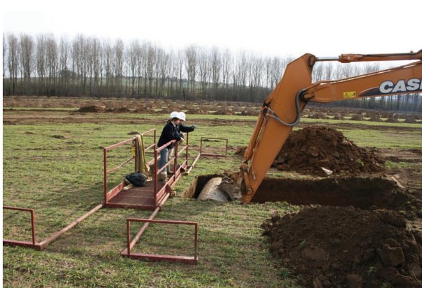
Fig. 4 - L'utilisation d'un balcon passerelle en métal permet aux agents de suivre l'extraction des sédiments et de relever les niveaux d'apparition des différentes couches en toute sécurité, diagnostic de E. Goval (photo M. Talon).
