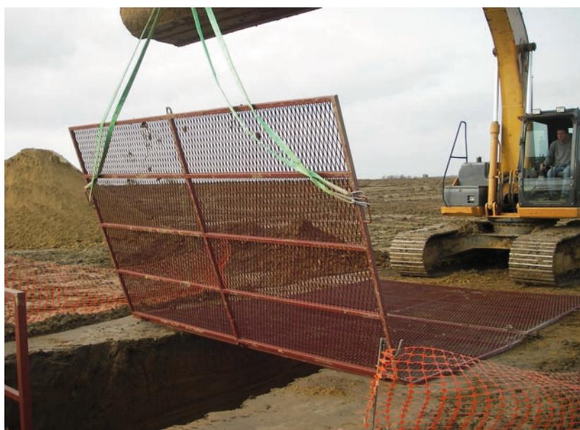
Fig. 6 - Un triptyque de panneaux en métal permet de fermer et protéger l'ouverture du puits en cas de prolongation sur plusieurs jours du sondage, diagnostic de N. Sellier (photo N. Sellier).
